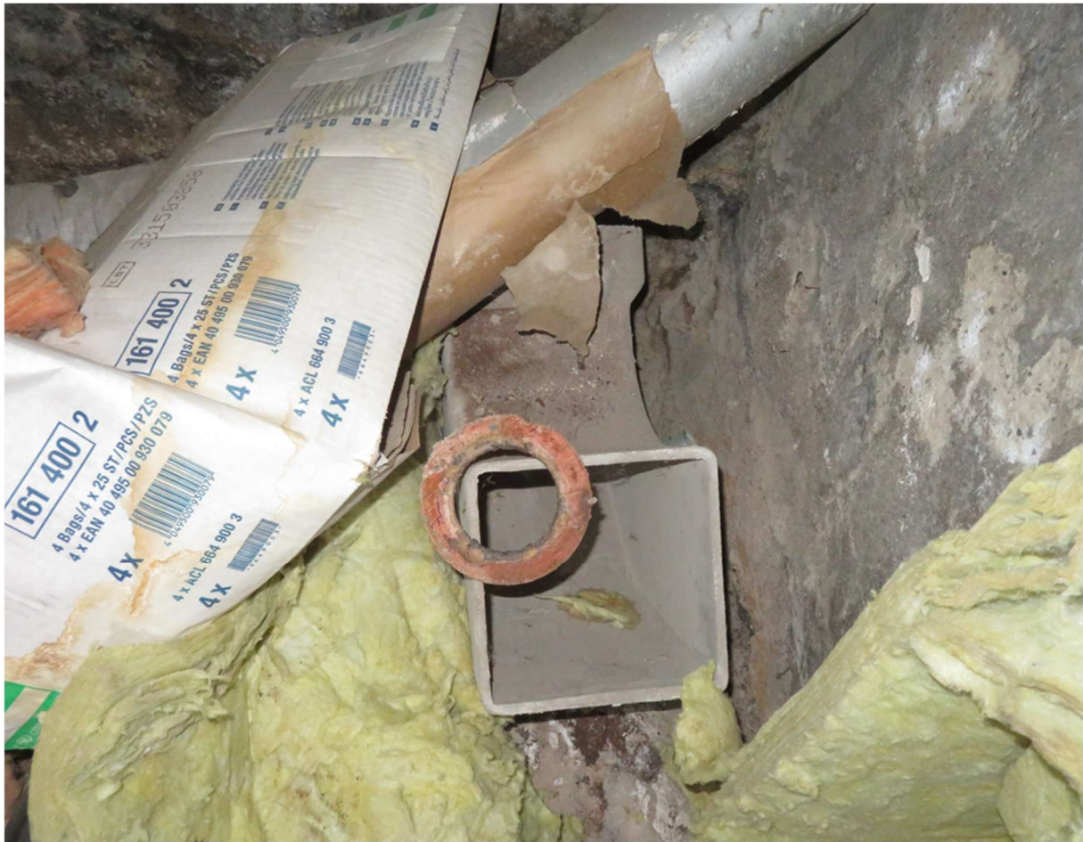
Figure N°5 – Conduit en fibres-ciment stocké et joint
