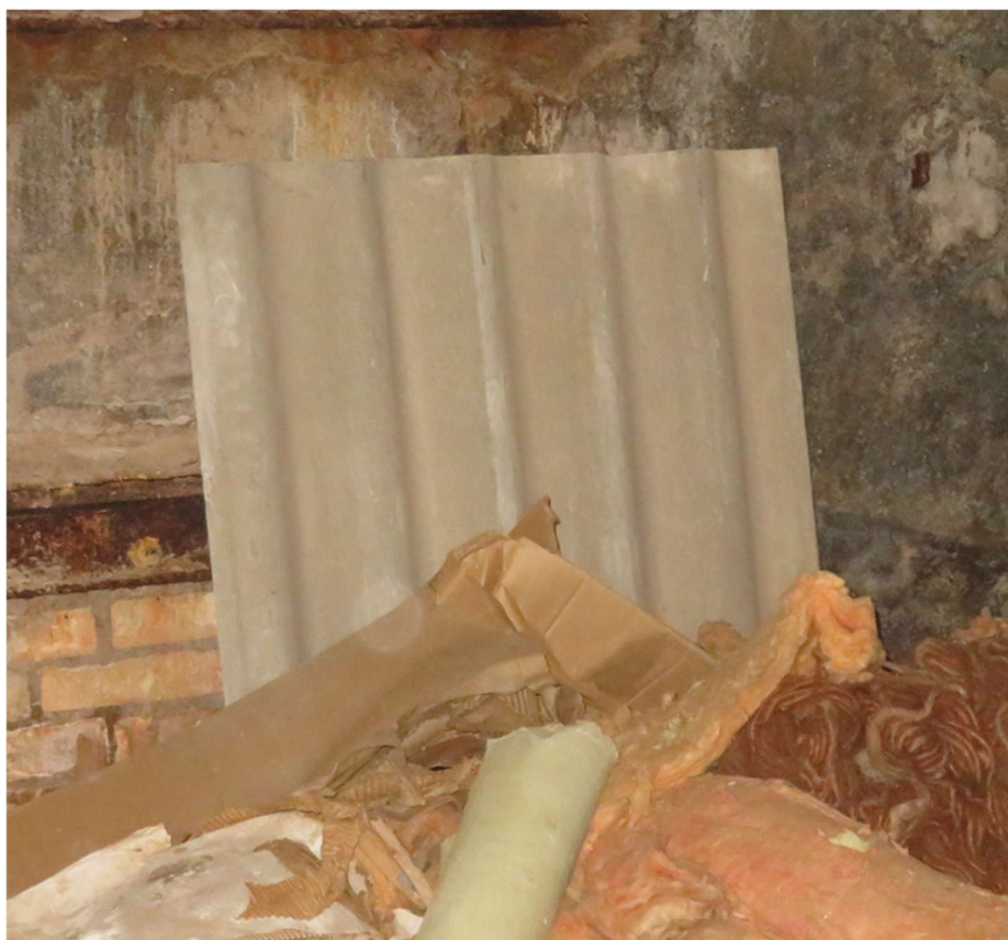
Figure N°4 – Plaque en fibres-ciment stockée
