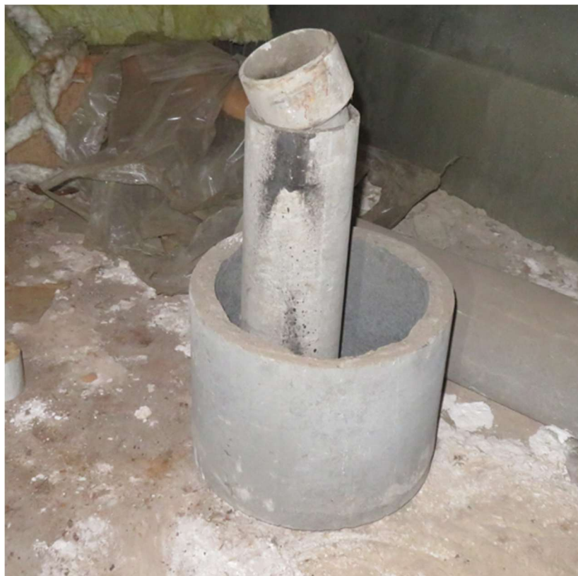
Figure N°3 – Conduit en fibres-ciment stocké
